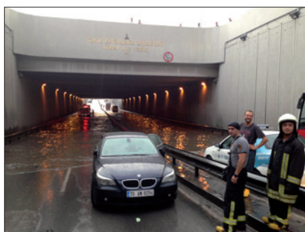
Obr. 2. Zatopený podjezd bez dálkového monitorování po prudkém dešti
