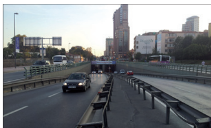
Obr. 1. V Istanbulu bylo postaveno 62 podjezdů
