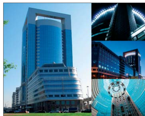
Obr. 6 Severní věž (North Tower)
